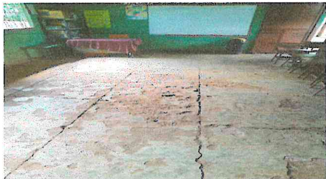
Foto1: Cambio de piso de concreto por cerámico
