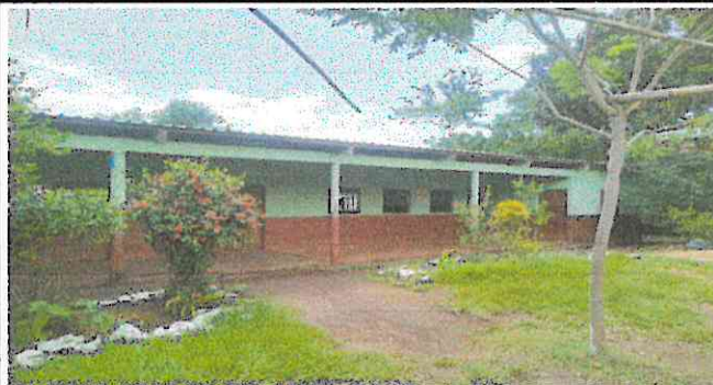
Foto 4: Implementación de canales
